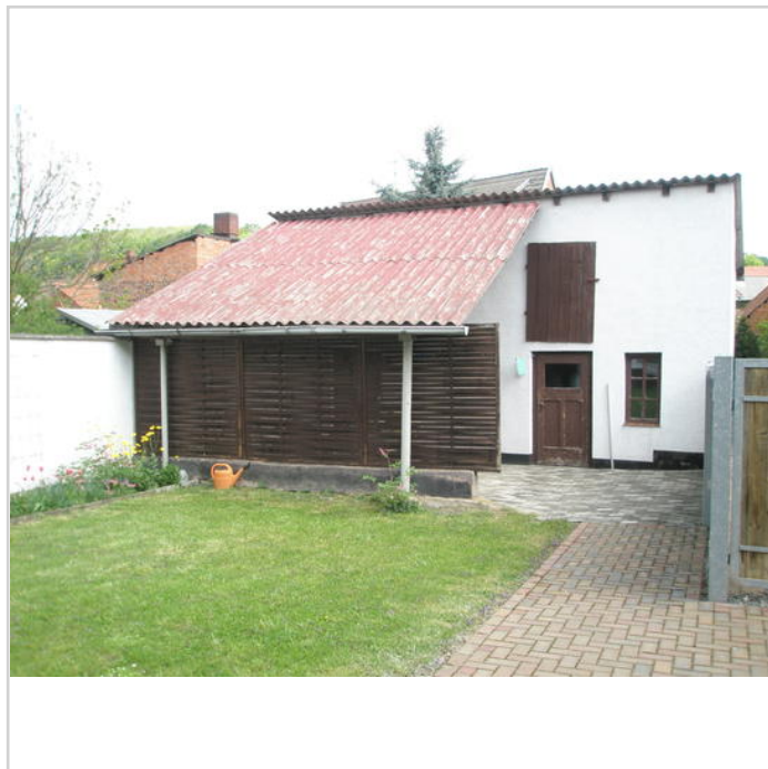
Carport u. Nebenglass
